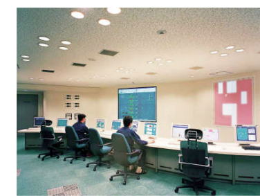
発電施設の中央コントロール室
