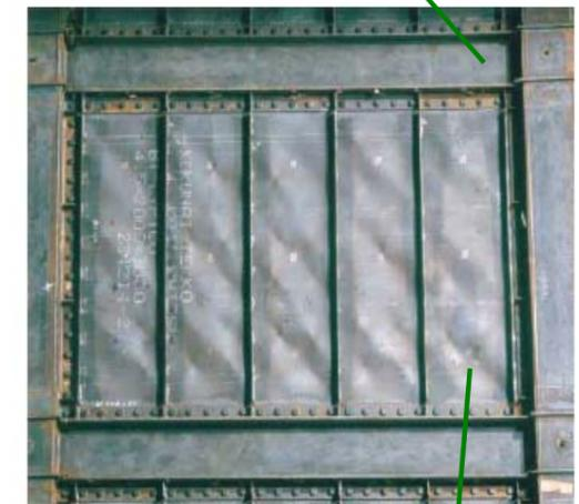
鉄の壁が地震エネルギーを吸収して歪む
