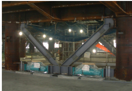
セミアクティブ型オイルダンパー（六本木ヒルズ森タワー内356箇所設置）
