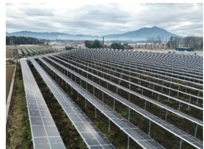
営農型太陽光発電所 (茨城県筑西市)
