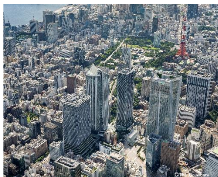
「虎ノ門ヒルズ ステーションタワー」外観 (画像右)
