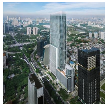
「JAKARTA MORI TOWER」外観
