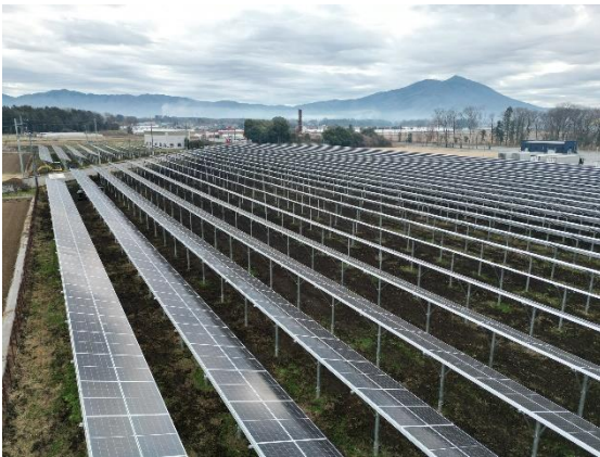
発電所(航空写真)
