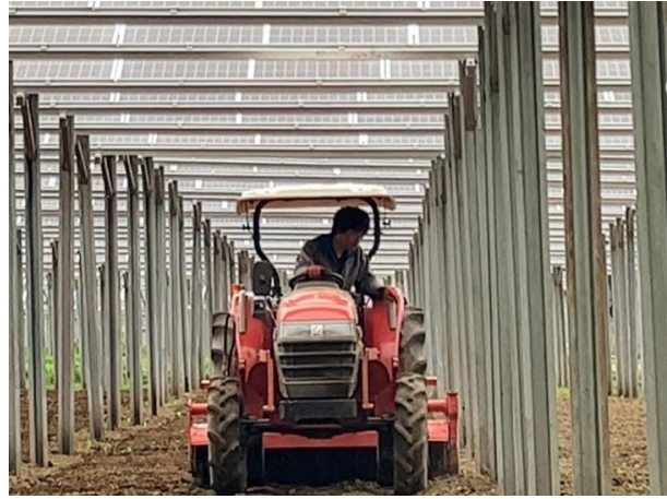
営農型太陽光発電所イメージ(写真株式会社エコ革が実際に施工した実例、二本松営農ソーラー株式会社提供)
