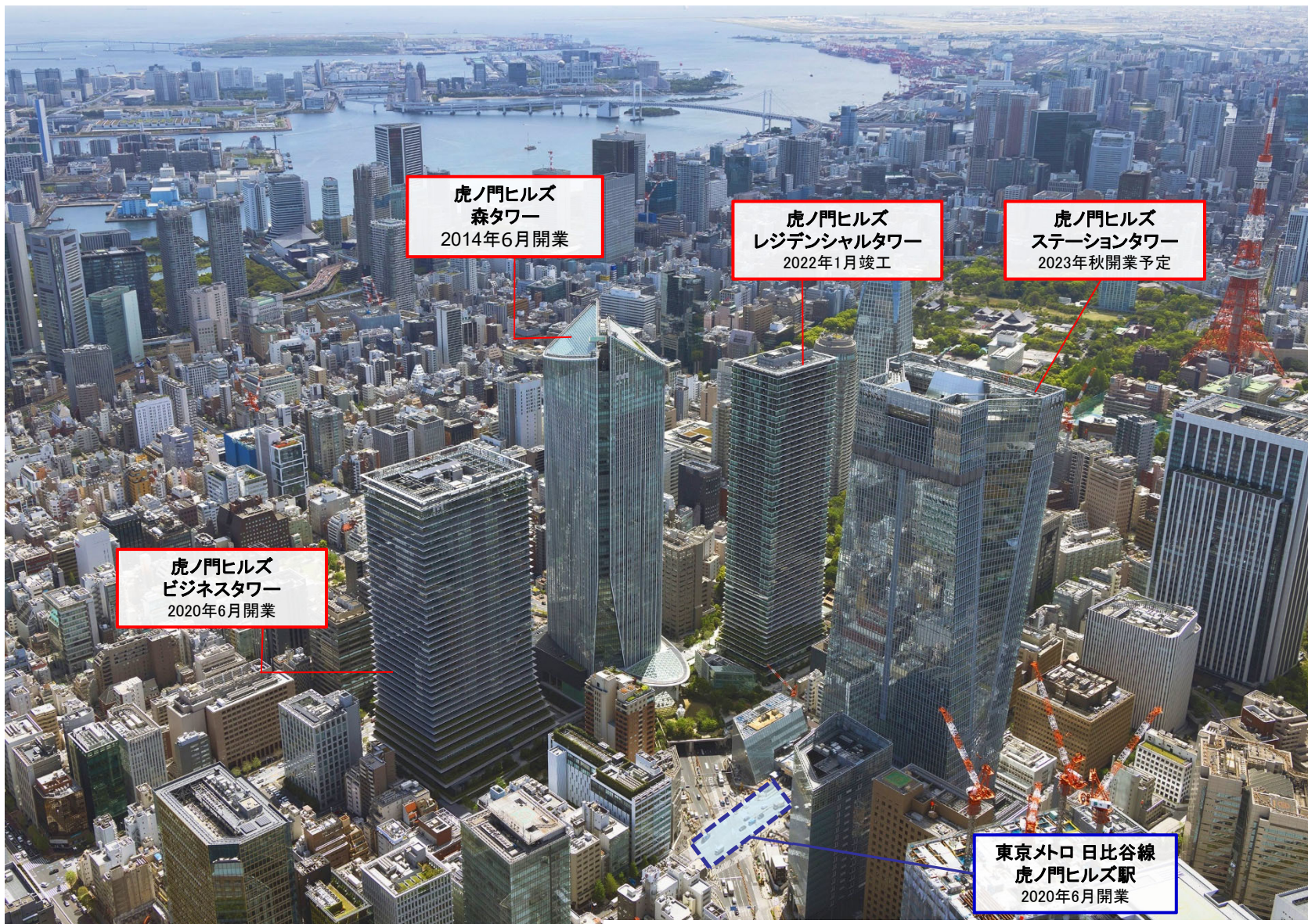
虎ノ門ヒルズエリアプロジェクト工事現況(2023年4月17日撮影)
