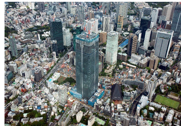
現場写真(2022年10月撮影)
