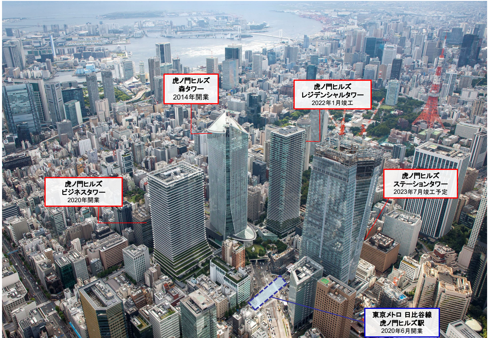
虎ノ門ヒルズエリアプロジェクト工事現況(2022年10月撮影)
