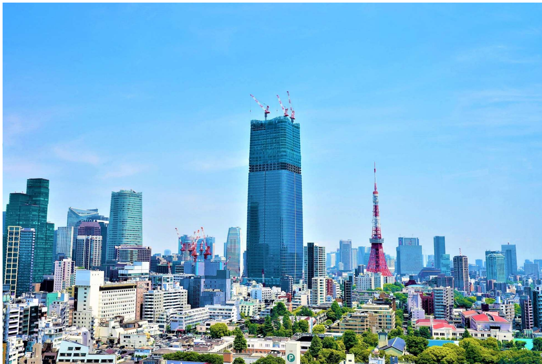
虎ノ門・麻布台プロジェクト工事現況(2022年5月撮影)
