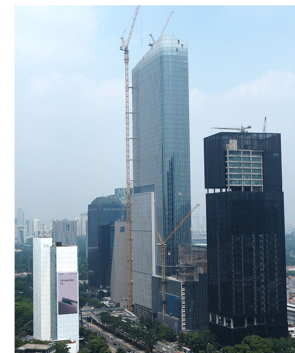
現場写真(2021年9月撮影)
