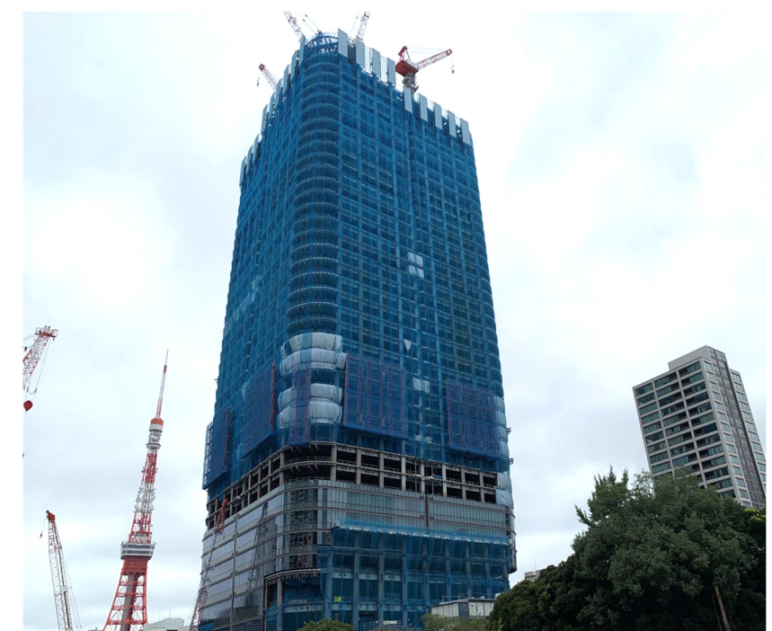
現場写真(A街区、2021年9月撮影)
