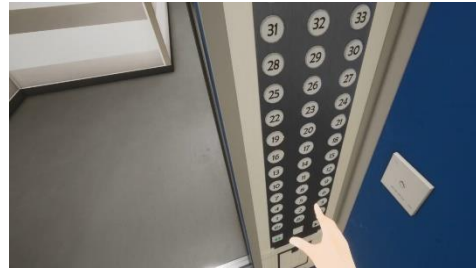
②非常用エレベーターの一次消防運転の操作
