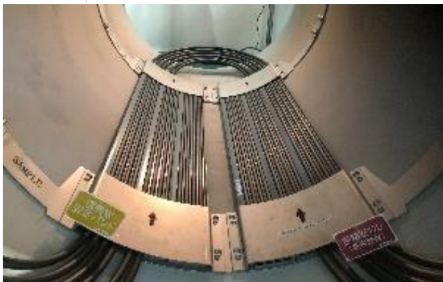
下水道管底の熱交換器(イメージ)
