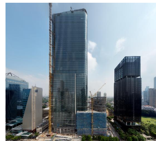
現場写真(2021年4月撮影)
