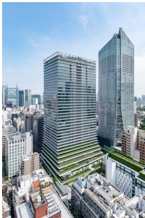
虎ノ門ヒルズ ビジネスタワー 外観
