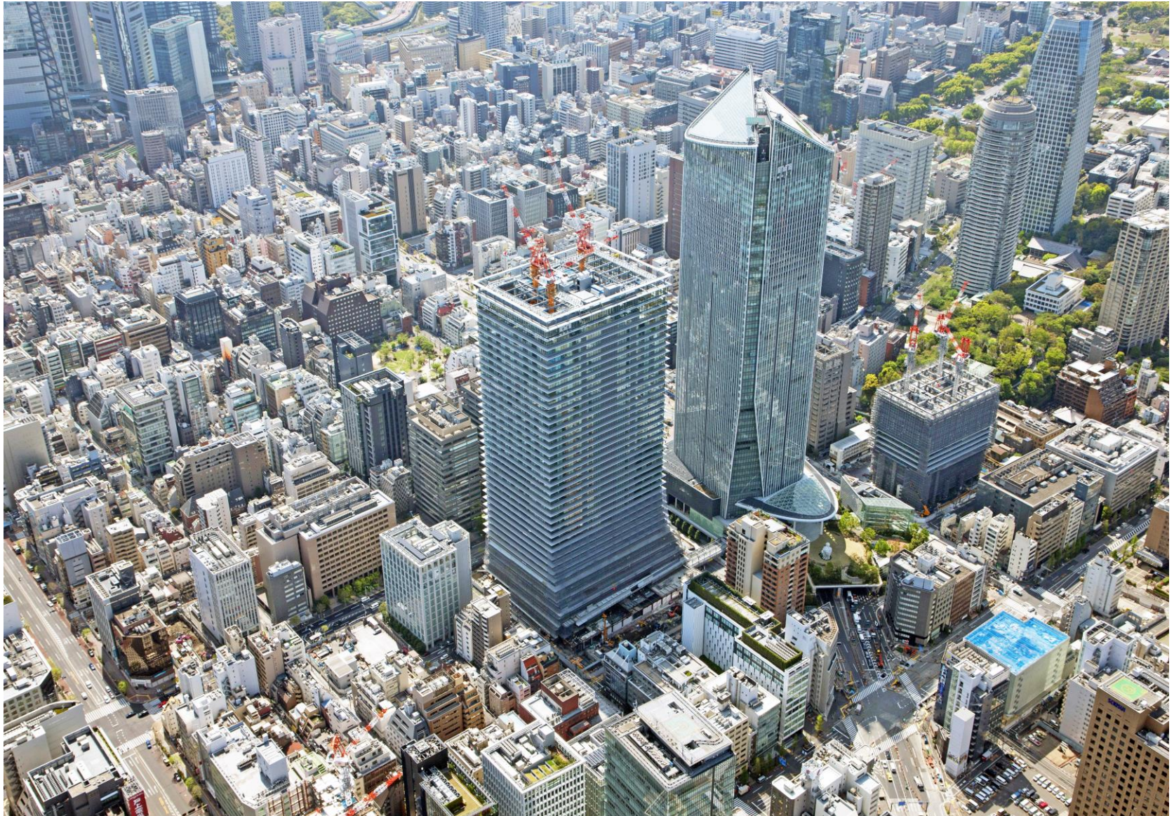
虎ノ門ヒルズビジネスタワー 工事現況(2019年4月撮影)
