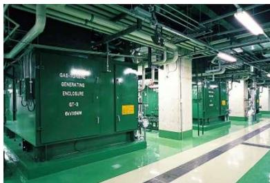
蒸気噴射型ガスタービン
