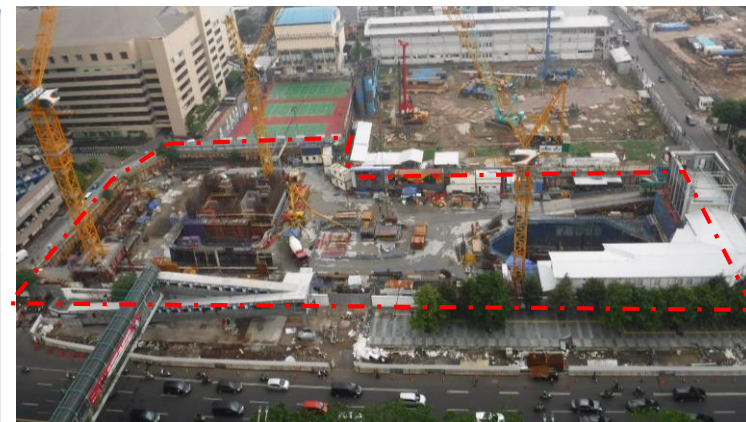
現場写真(11月撮影)
