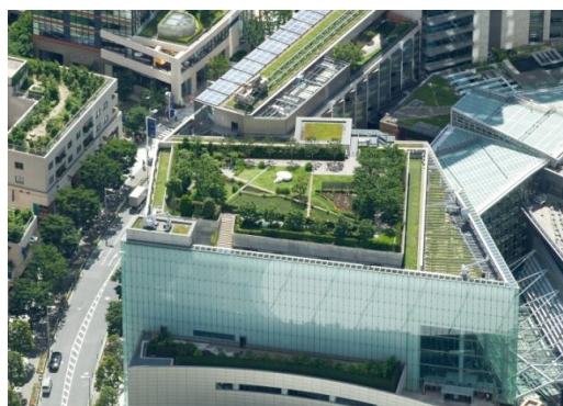
制振装置として活用した屋上庭園(六本木ヒルズ)
