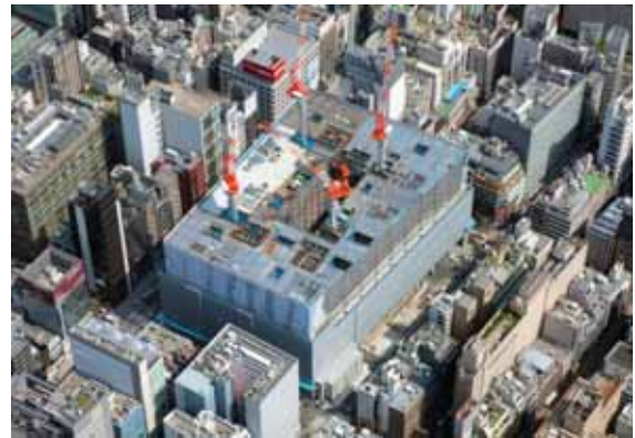
工事が進むプロジェクト地の様子(4月25日時点)
