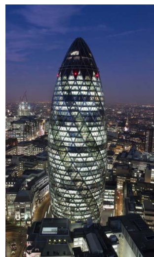
《スイス・リ本社ビル (30 セント・メアリー・アックス)》 1997-2004年 ロンドン 撮影：Nigel Young, Foster + Partners
