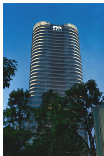
曲面のデザインを表現したアークヒルズ 仙石山森タワーの外観の照明
