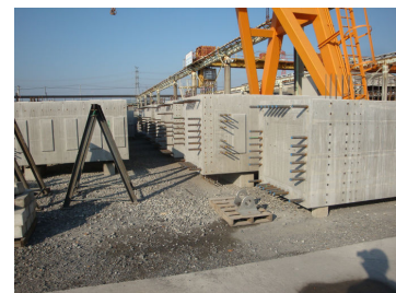
柱・梁は栃木県、茨城県の工場で製作
