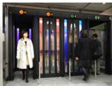
高層ビル特有の風が吹き抜ける現象を抑制し、エントランス部の空調効率を向上させる新出入口システム。軽量化した折戸により、素早い開閉と本質的な安全性を両立しています。「上海環球金融中心」(中国・上海)車寄せなど3カ所、「六本木ヒルズ森タワー」(東京・港区)の展望台出入口の2カ所に設置しています。
