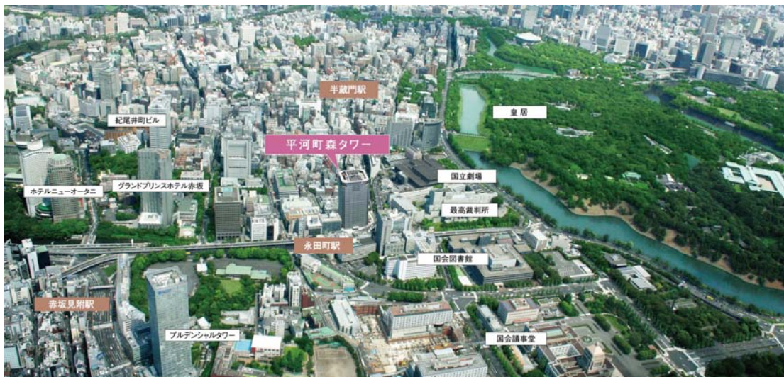
平河町森タワー周辺航空写真
