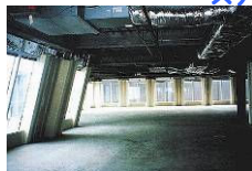
内装がほとんど施されていない状態
