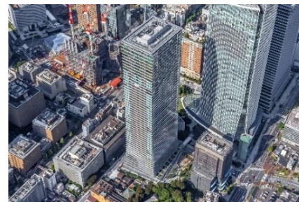
Construction site (October 2021)
