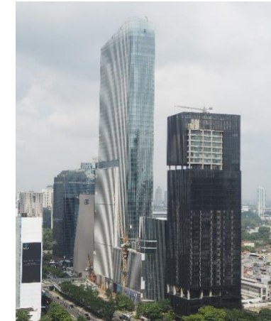
Construction site (March 2022)
