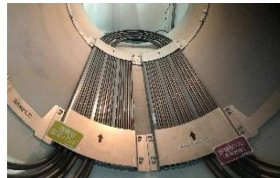
下水道管底の熱交換器(イメージ)
