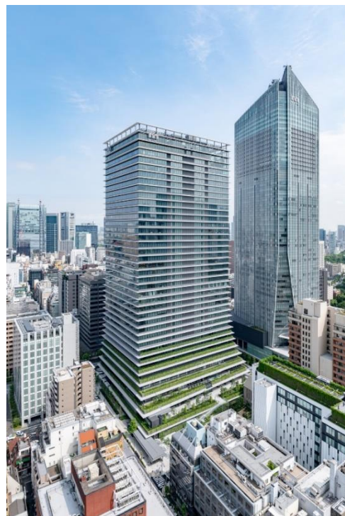
虎ノ門ヒルズ ビジネスタワー 外観
