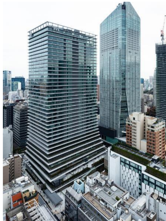
虎ノ門ヒルズ ビジネスタワー 外観(2020年1月撮影)
