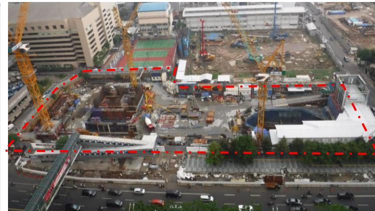
現場写真(11月撮影)
