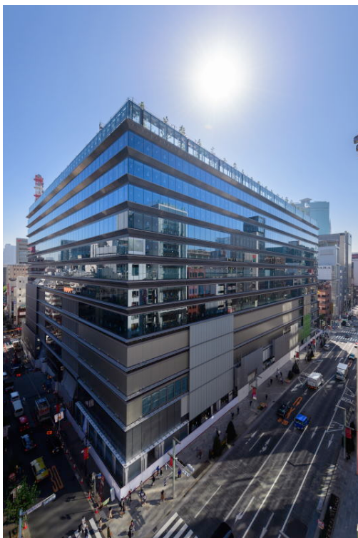
工事進捗状況(2016年10月撮影)
