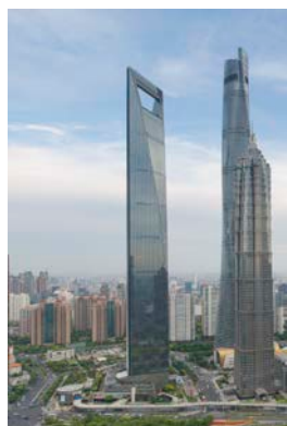
上海環球金融中心 2008年8月竣工
