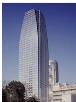
愛宕グリーンヒルズ MORIタワー
