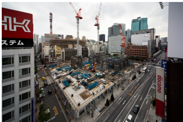
工事進捗状況（2015年10月23日撮影）
