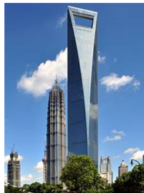
上海環球金融中心 2008年8月竣工
