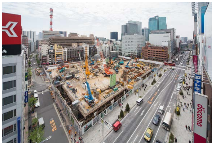
工事進捗状況（2015年4月28日撮影）
