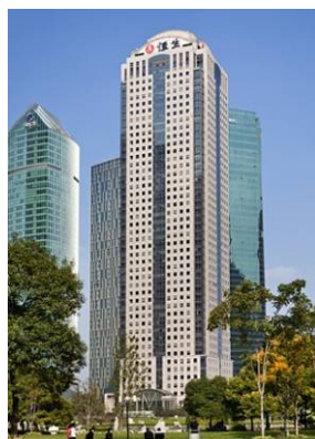
恒生銀行大廈 中華人民共和国上海市 1998年4月竣工 延床面積 116,824㎡ 事務所
