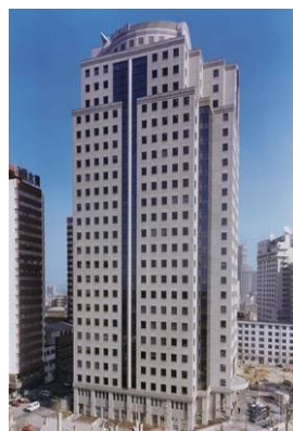
森茂大廈 中華人民共和国大連市 1996年10月竣工 延床面積 46,400㎡ 事務所
