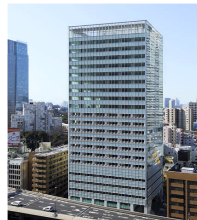
アークヒルズフロントタワー (事務所等の一部) 2011年1月竣工
