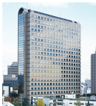
六本木ファーストビル 1993年10月竣工 延床面積:45,754㎡
