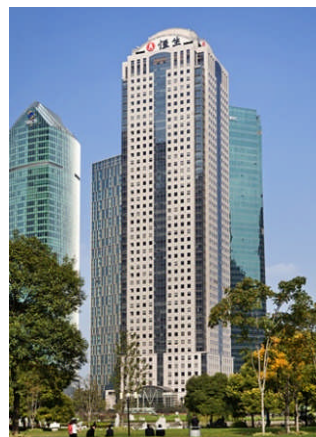
恒生銀行大廈 (中華人民共和国上海市) 1998年4月竣工 延床面積:116,824㎡
