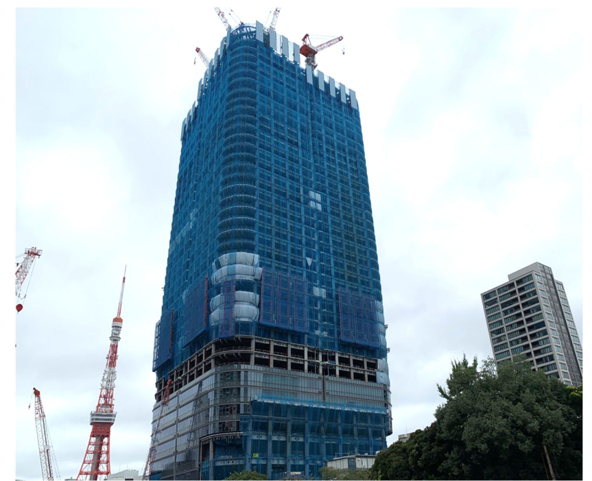
現場写真(A街区、2021年9月撮影)
