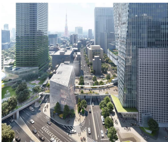
街区を跨いで街を繋ぐ幅員 20m の大規模歩行者デッキ
