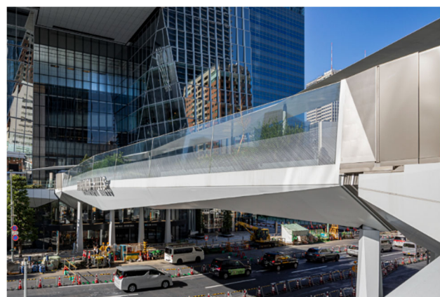
高欄ガラスは直接主構造に支持されており、ボルトや目地がなく、メンテナンス上も有利
