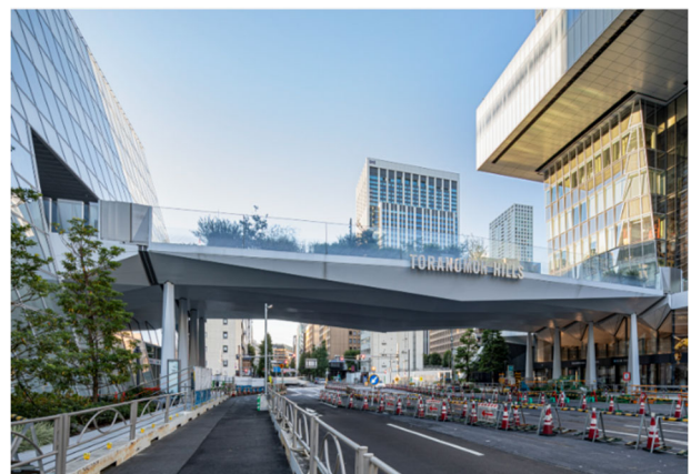
ステーションタワー（高層建築）とグラスロック（低層建築）という振動特性の異なる建築物と橋梁による構造的調和を実現
