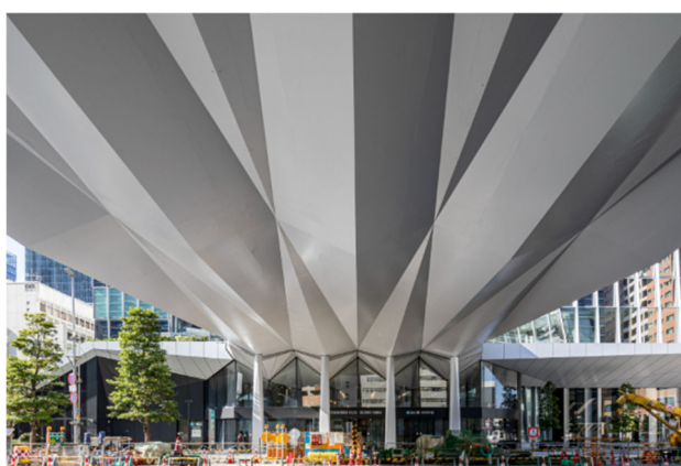
建物側の天井デザインとデッキが連続する主桁形状を採用 桁下には光が差し込み明るく開放的な空間を実現
