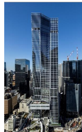
虎ノ門ヒルズ ステーションタワー
