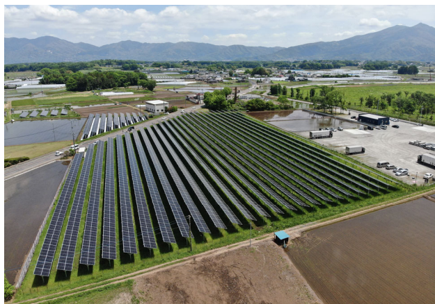
筑西市桑山営農型太陽光発電所
