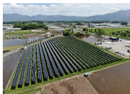
筑西市桑山営農型太陽光発電所
