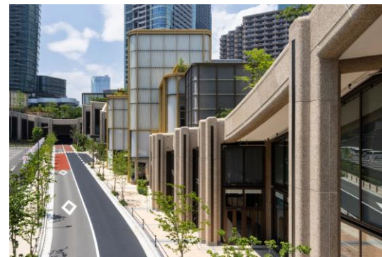
地上部の「八幡通り」
