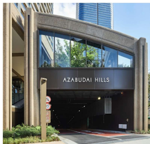
東西をつなぐ「八幡通り」
