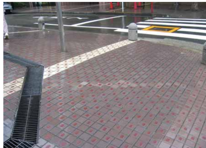
外構床タイル滑止めシート張り
