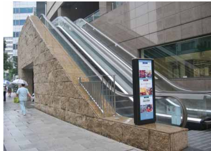
傾斜壁下部の侵入防止柵設置
