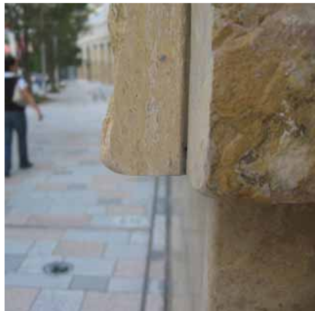
突出した石板端部の面取り加工
