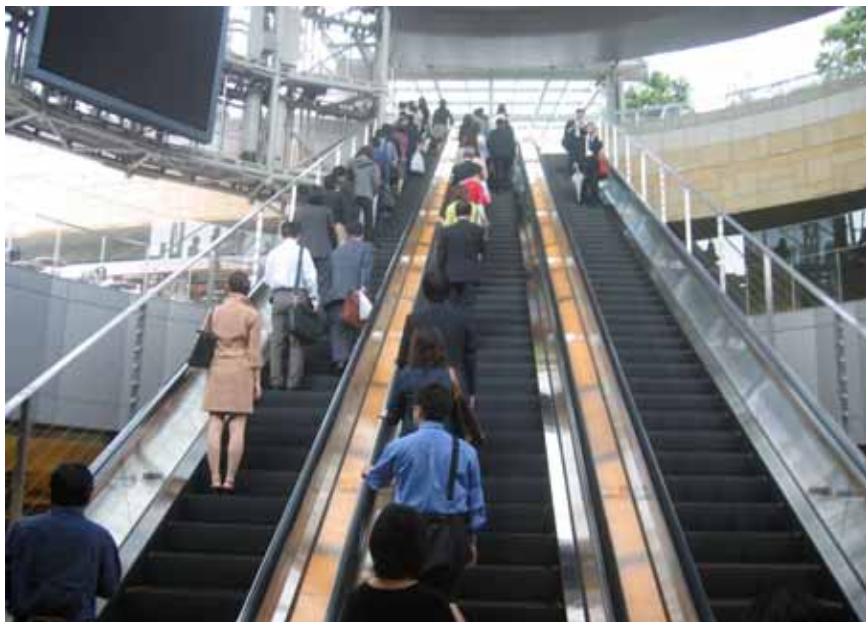
エスカレーター両サイドの落下防止柵設置
