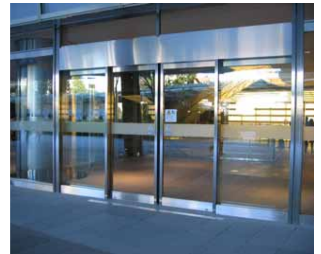
回転扉撤去部分の新自動扉
