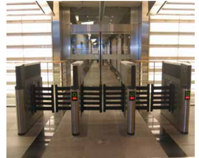
コアに新設した自動扉
