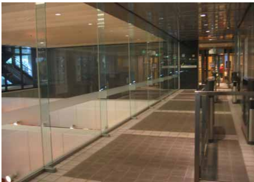
ガラススクリーン衝突防止フィルム張り
