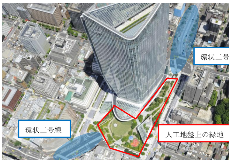
立体道路制度により誕生した人工地盤上の緑地空間
