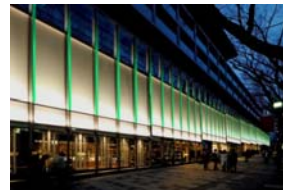
外壁照明 ※イメージ
